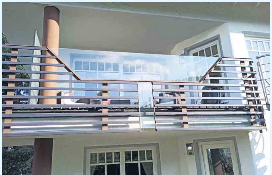
Moderne Balkongestaltung von der Tischlerei Holztec
