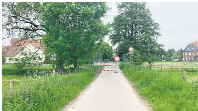
Für den (Pkw- und Lkw-)Verkehr gesperrt: Die Brücke zwischen Südhang und Rosenstraße in Bad Wünnenberg.
