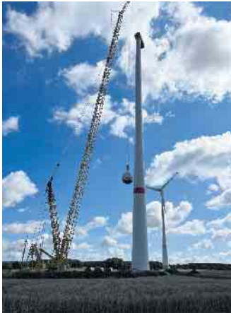
Die Narbe sitzt. Windkraftanlage wird bei Windstille vervollständigt. Fotos: C.Zaragoza
