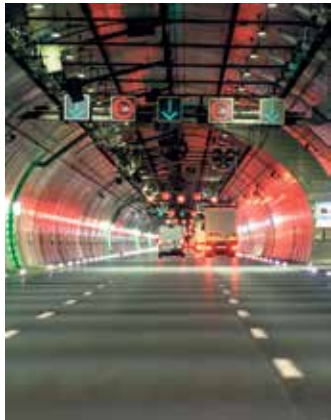
In Tunneln gibt es viele hoch entwickelte Sicherheitseinrichtungen: Videoüberwachung und Notrufstationen mit Verbindung zur Tunnelleitzentrale sind im Notfall entscheidend und sorgen für maximale Verkehrssicherheit. Foto: DJD/Fernstraßen-Bundesamt
